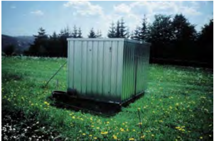
Abb 6: In den Außenzaun eingebaute, transportable Hygieneschleuse (Foto: K. Thies)
