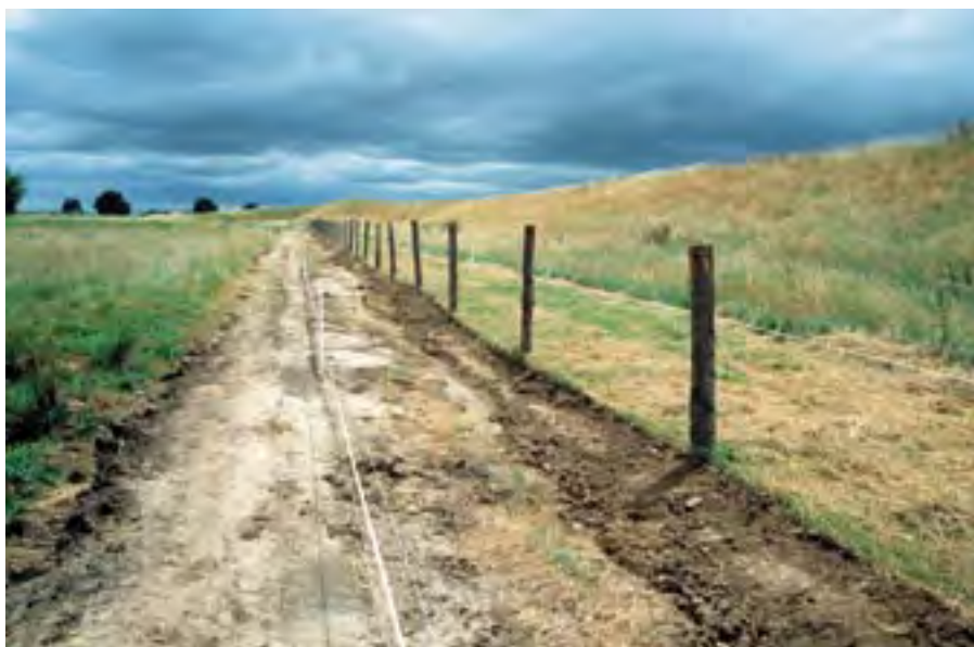
Abb. 1: Neu errichteter Zaun in Lenzen. Rechts der wilddichte und eingegrabene Außenzaun, links der Elektrozaun. Der Korridor dazwischen beträgt 2 m. (Foto: B. Beinlich)
